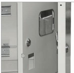
Оперативная панель имеет окно для снятия показаний электросчетчика и прорез для доступа к аппарату защиты.
